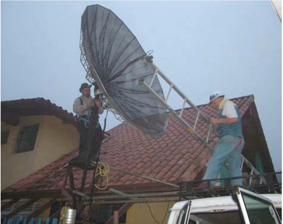
Figure 11.30: Carlo et Ermanno démontent l'antenne satellite fournie par M. Ismael Santos.
