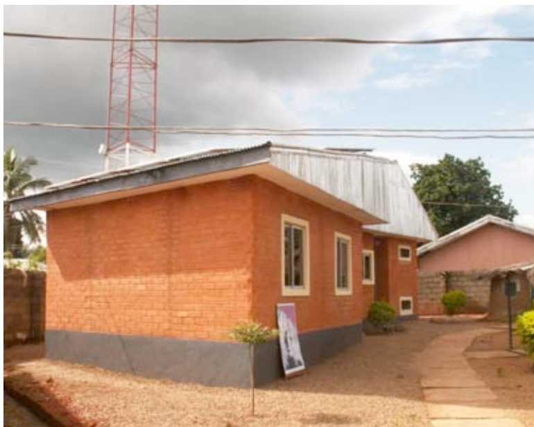
Figure 11.2: Le NOC est construit par des briques en latérite produites localement et posées par les jeunes de Kafanchan.
