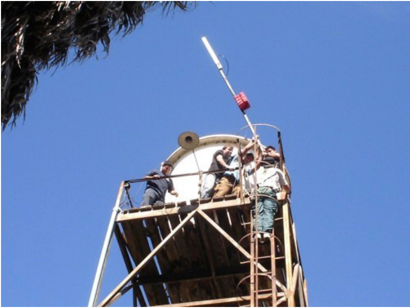
Figure 11.24: Implémentation d'un noeud sur un château d'eau dans Batuco, région métropolitaine, fournissant le backhaul pur le télécentre de Cabрати.
