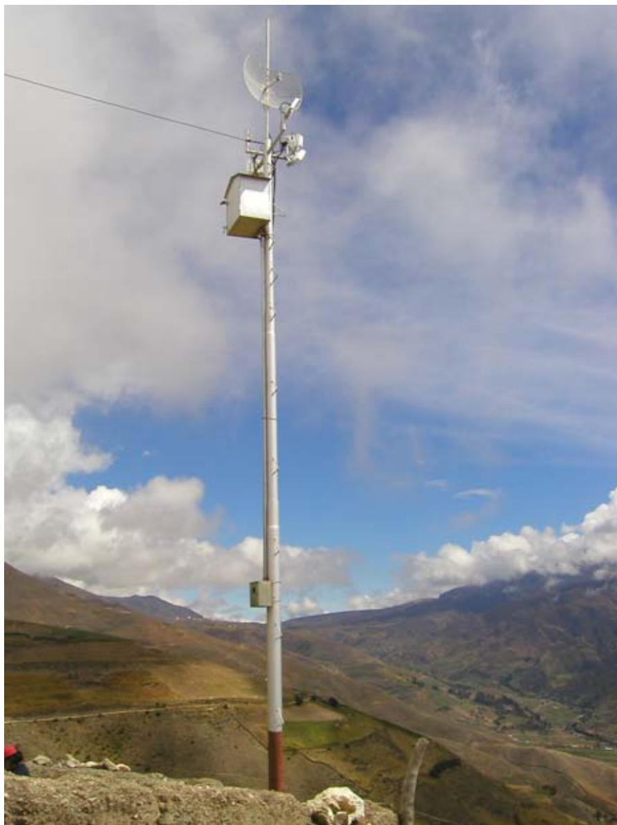
Figure 8.3 : Un simple mat autoportant
