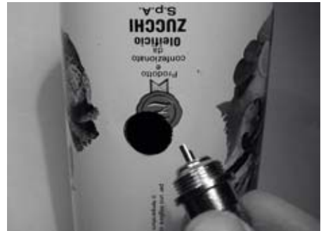
Figure 4.37: Percez soigneusement un trou pilote, puis utilisez une mèche plus grande pour terminer le travail.
