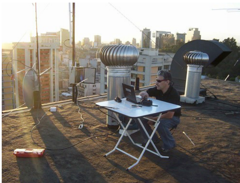
Figure 11.23: Nœud de la ville relié au nœud au sud de Santiago. Notez l'antenne parabolique utilisée pour le backhaul et l'antenne sectorielle pour connecter les clients.
