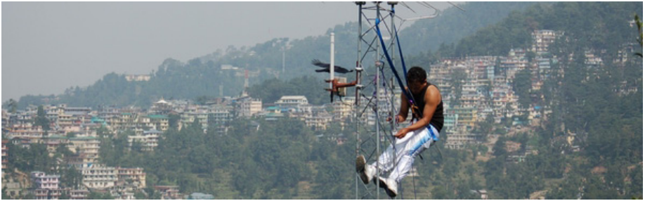
Figure 11.5: Installateur Dharamsala travaillant sur une tour
