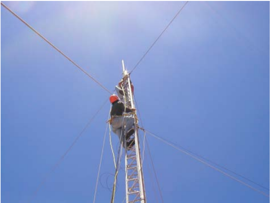
Figure 8.2 : Un pylône haubané escaladable
