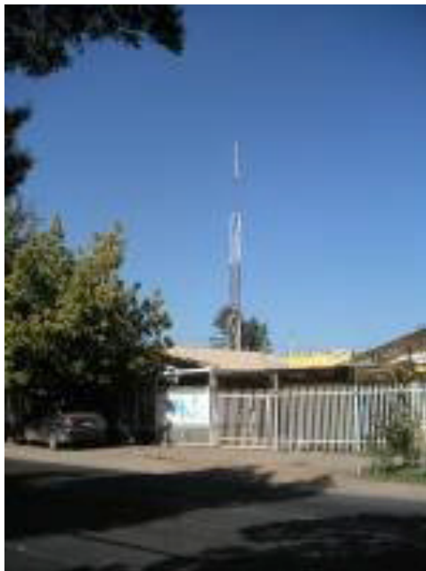
Figure 11.21: Un nœud dans le sud de Santiago, constitué d'une tour de 15 m, une antenne de type Trevor Marshall 16 +16 et 30 clients. Le nœud est connecté à un nœud de la ville à plus de 12 km de distance.
